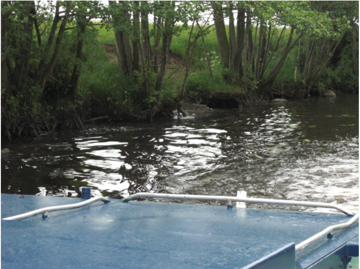
Figur 13. Eroderad strand i Graften 2010-06-13. Även på de platser där det inte går ner kor och dricker är stranden eroderad i Graften. Erosionen beror på vattnets rörelser i vattendraget, antingen p.g.a. häftiga flöden eller p.g.a. vågrörelser av vind eller båttrafik. Erosionen har lett till att trädens rötter blottats. Foto: Olof Jönsson
