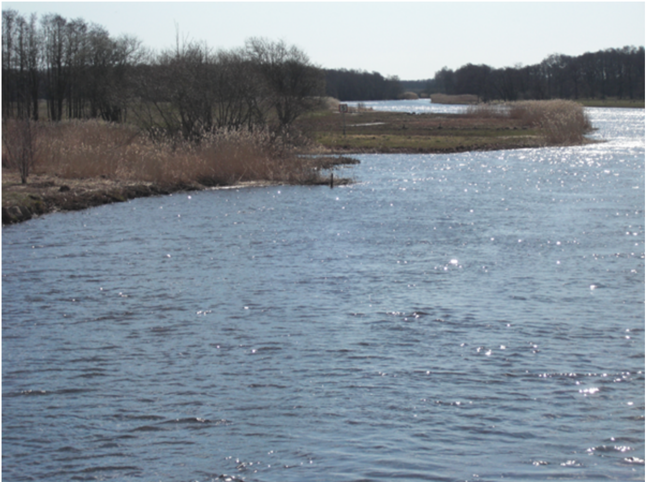
Figur 4. Graftens inlopp sett från Helge å uppströms inloppet 2010-04-16. Inloppet är mycket igenvuxet och vattnet trycks in vinkelrätt från Helge å snarare än att det rinner in i åns strömningsriktning. Foto: Olof Jönsson.
