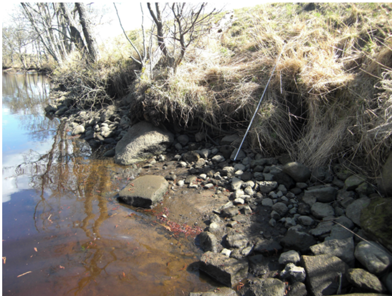
Figur 19. Erosion i Möllerännan 2010-04-16. Svallvågor från båtar i kanalen gör att sanden i de branta strandvallarna eroderar. Hastighetsgränsen i hela gamla åfåran är 5 knop. Begränsningen följs dock dåligt enligt boende i området. Foto: Olof Jönsson.
