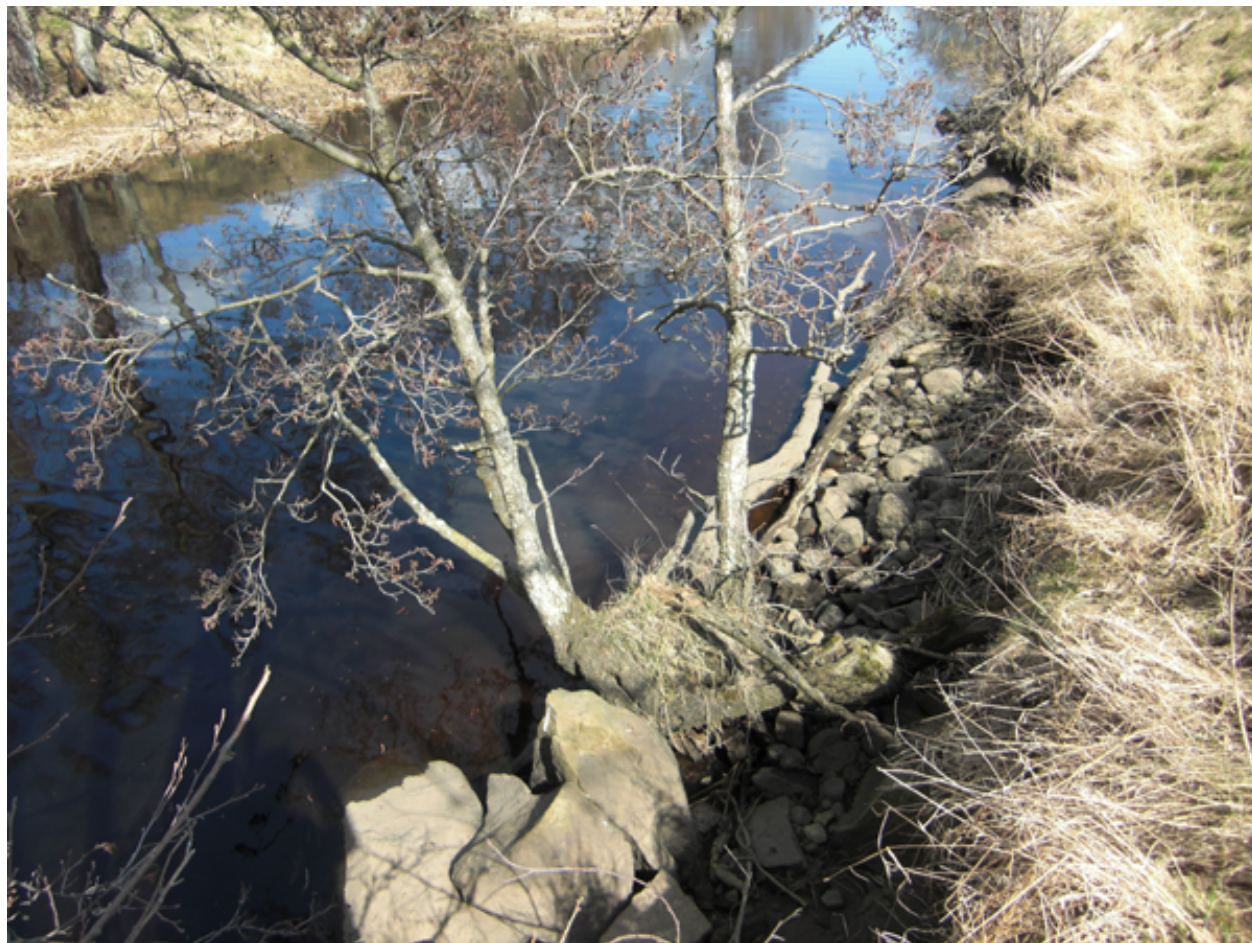
Figur 20. Alar på väg att falla ner i Möllerännan p.g.a. erosion 2010-04-16. Foto: Olof Jönsson.
